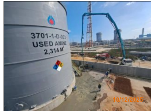
งานเข้าแบบและเทพื้นคอนกรีต
