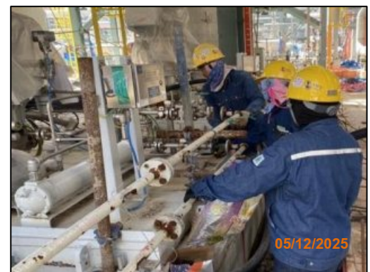
งานเชื่อมประกอบและติดตั้งวาล์ว
