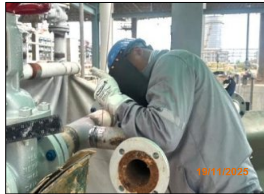
งานเชื่อมประกอบและติดตั้งวาล์ว
